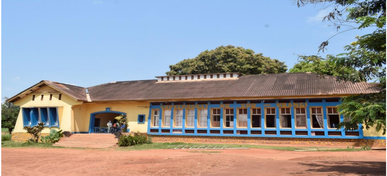
Photo n°1 : Bâtiment du Gouvernement.
